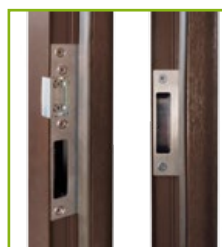
otwory zaczepowe ościeżnicy aluminiowej
