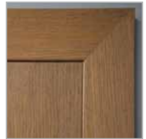
łączenie opasek pod kątem 45°
