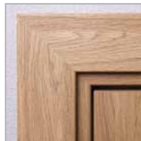
standardowe łączenie opasek pod kątem 45°
