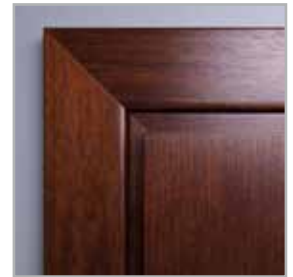
łączenie opasek pod kątem 45°
