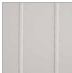
frezowanie na powierzchni skrzydła
