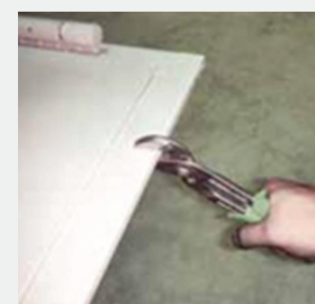
Wyłamać część dolnej belki ościeżnicy
